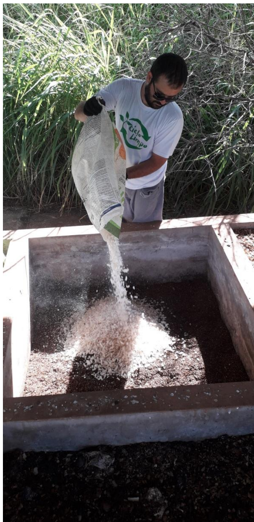
Foto 7 e 8. Montagem de uma baia (pilha de compostagem), contendo serragem, resíduos orgânicos da OKA BIOEMBALAGENS e resíduos orgânicos domiciliares provenientes de residências e restaurantes.
